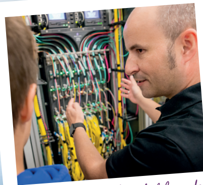
Durch diese Glasfaserkabel werden all die Daten geleitet.
